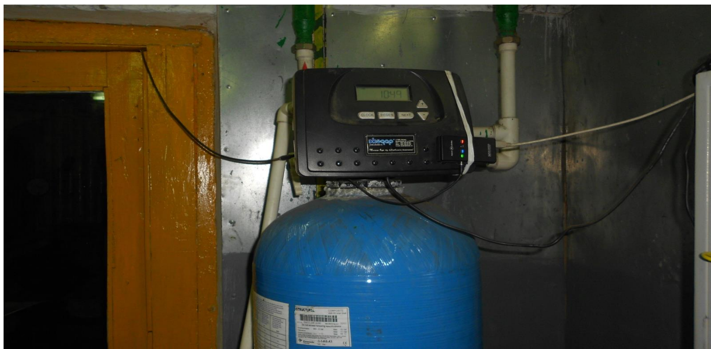
Рис 4 Система химической водоподготовки в котельной с. Дзякино
