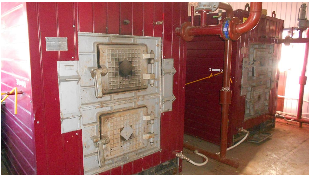
Рис 6 Внешний вид твердотопливных котлов котельной №2
