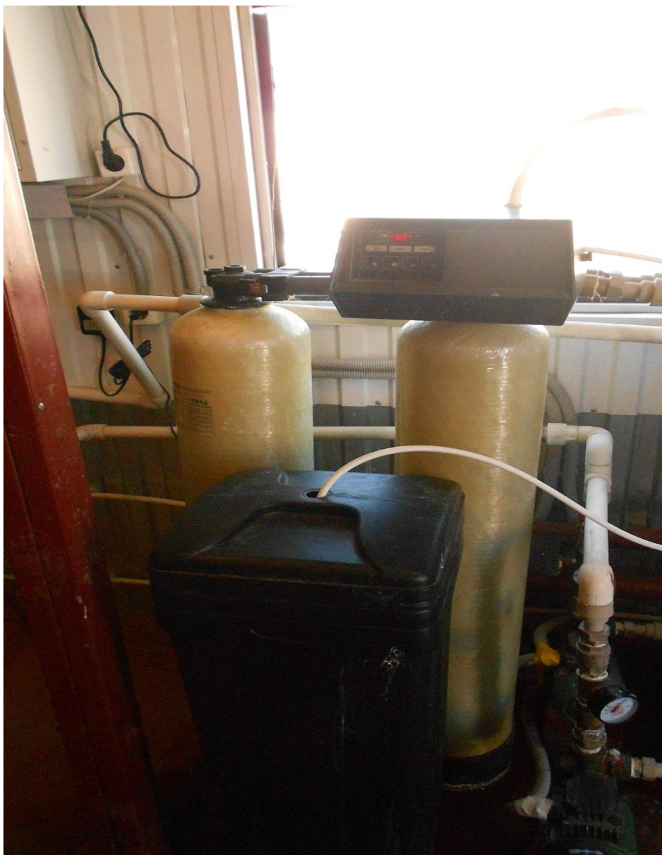
Рис 8 Внешний вид химводоподготовки в котельной №2
