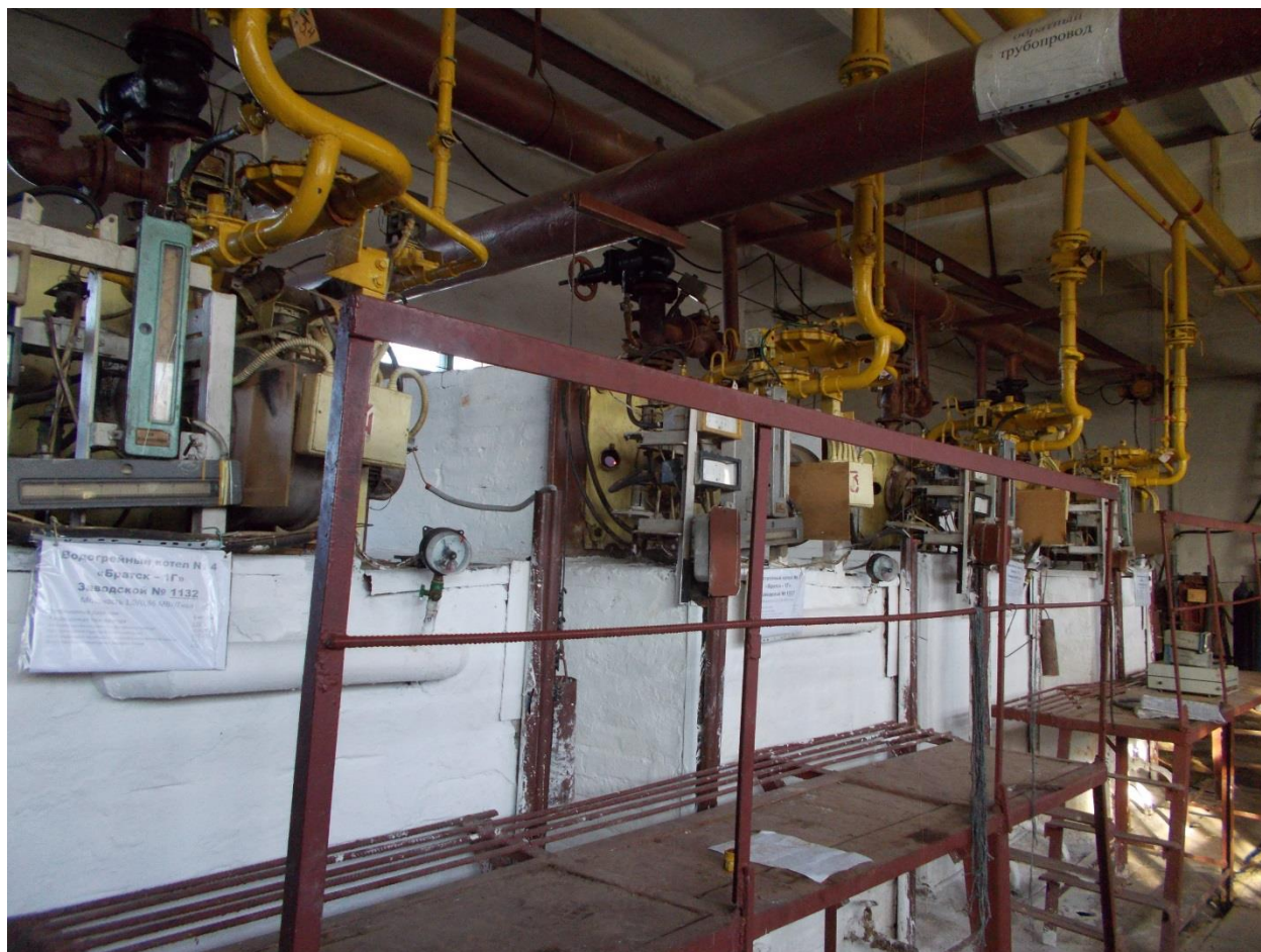
Рис 3 Газовые котлы, расположенные в котельной д. Штанигурт
