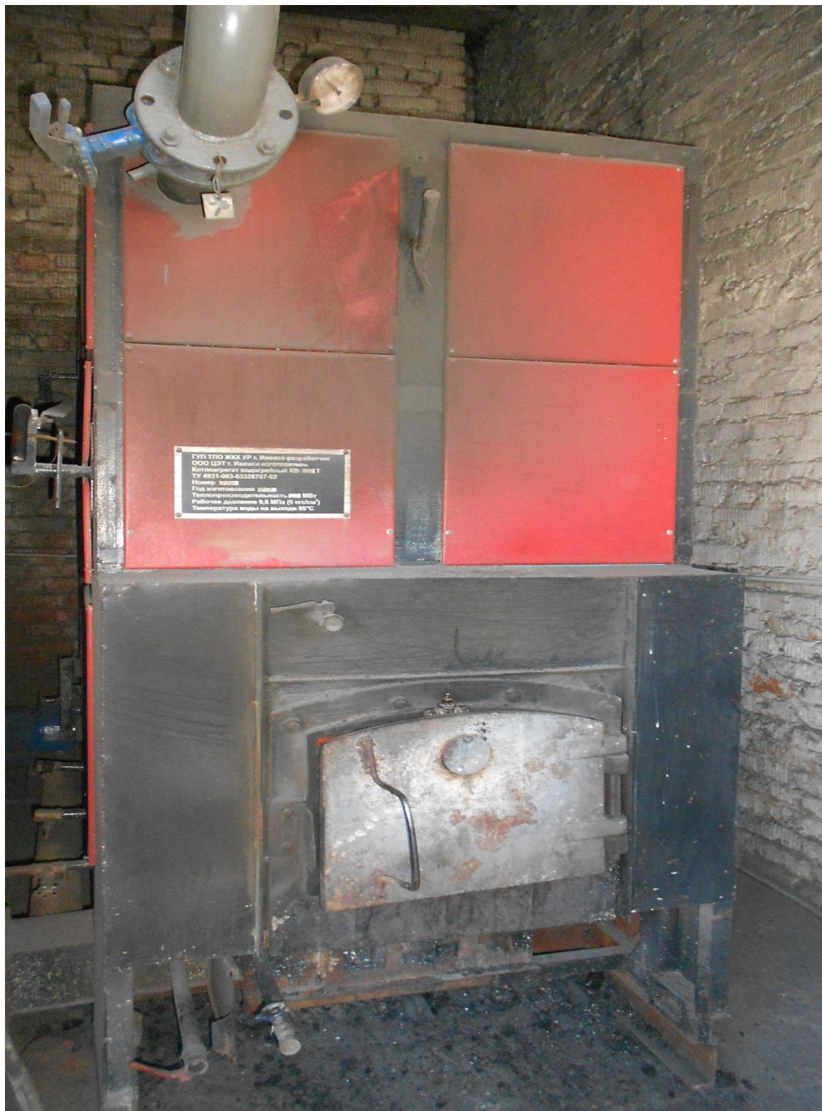
Рис 10 Внешний вид твердотопливных котлов котельной № 3
