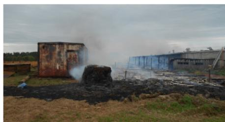
результате пожара огнем уничтожено здание телятника дощатое, повреждены отделка бытовки металлической, кровля молочно-товарной фермы, рулон соломы. Общая площадь пожара составила 310 кв.м. Причиной пожара является возгорание горючих материалов вследствие нарушения правил пожарной безопасности при проведении огневых работ.
