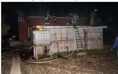
К прибытию пожарных происходило открытое горение кровли бани, наблюдалась угроза соседним строениям. Огнем повреждена обрешетка кровли гаража и бани. Общая площадь пожара составила 20 кв.м. Причиной послужило отсутствие противопожарной разделки дымохода печи бани.
