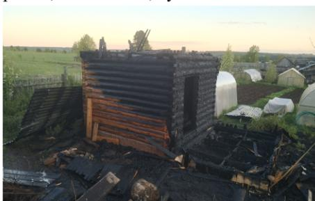
прибытию пожарных горела баня открытым пламенем по всей площади. В результате пожара уничтожен дощатый предбанник, кровля бани, поврежден сруб бани. Площадь пожара составила 15 кв.м. Причиной послужило отсутствие противопожарной разделки дымохода печи бани.
