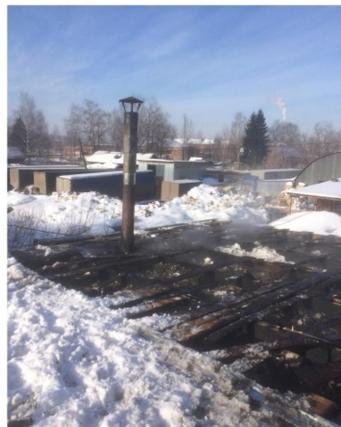
по адресу: г. Глазов, Красногорский тракт. Огнем повреждена обрешетка кровли склада на площади 20 м<sup>2</sup>. Причина пожара – неправильное устройство отопительных печей и дымоходов (отсутствие разделки дымохода печи).
