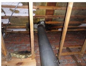
устройство дымохода печи (металлическая труба выполнена вплотную к деревянным конструкциям обрешетки кровли).
